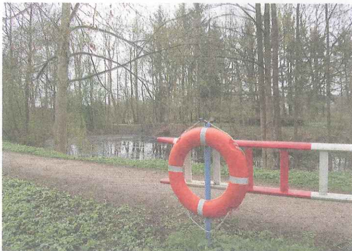
Die Regenrückhaltebecken wurden wieder instand gesetzt.
