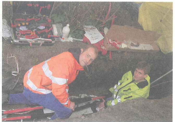
Die Stadtwerke-Mitarbeiter Jan-Hendrik Klose und Niclas Lilienthal arbeiten an den Stromleitungen.
